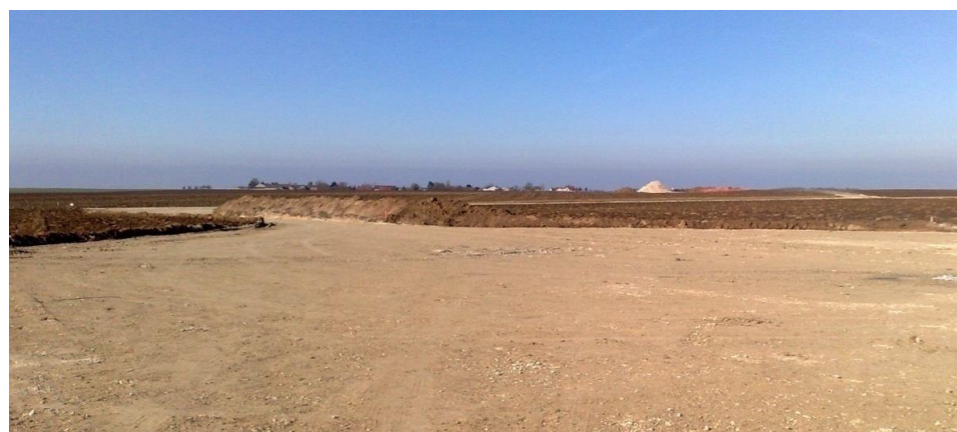
Figure 93 : Exemple d'aire de montage, grave compactée sur géotextile
